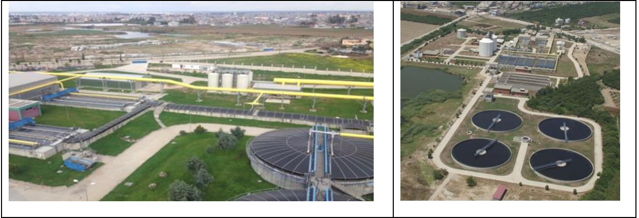
Şekil 12. Yüreğir Atıksu Arıtma Tesis
